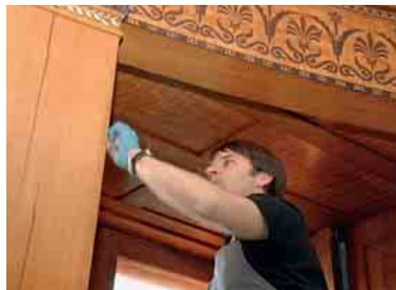
Restaurator Lars-Erik Böhner bei der Schellackballenpolitur von Holzoberflächen im Empfangszimmer des Oldenburger Schlosses, das im März 2011 nach langer Renovierung für die Öffentlichkeit geöffnet wurde.
